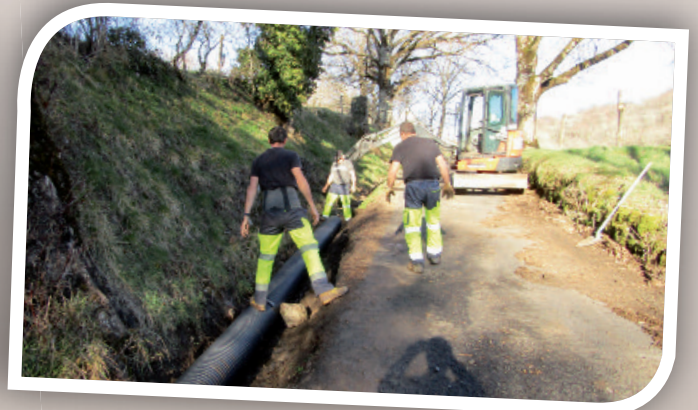
Busage et remblaiement d'un fossé route de Onzac.
