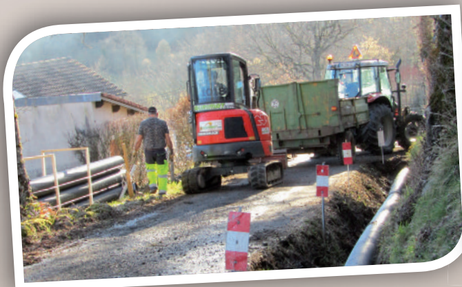
Busage et remblaiement d'un fossé route de Onzac.
