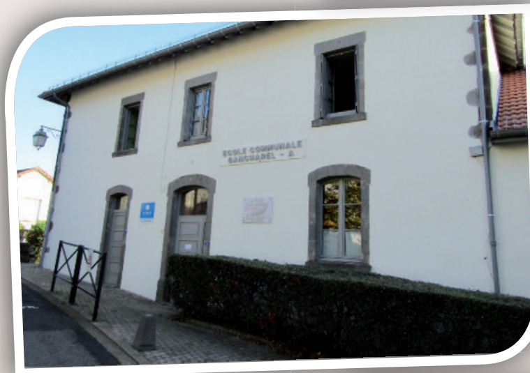
Ravalement façades école et logements locatifs.
