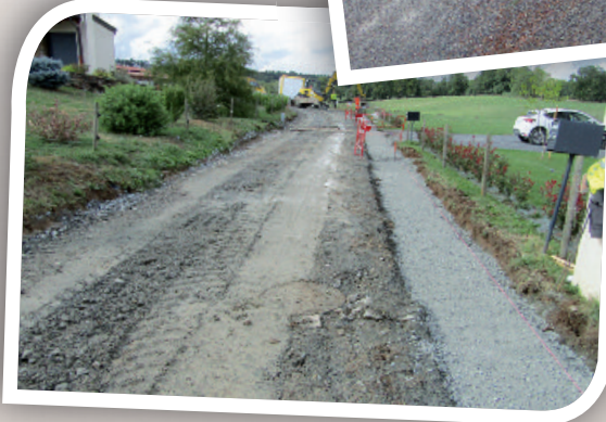
Busage et remblaiement d'un fossé route de Onzac.
