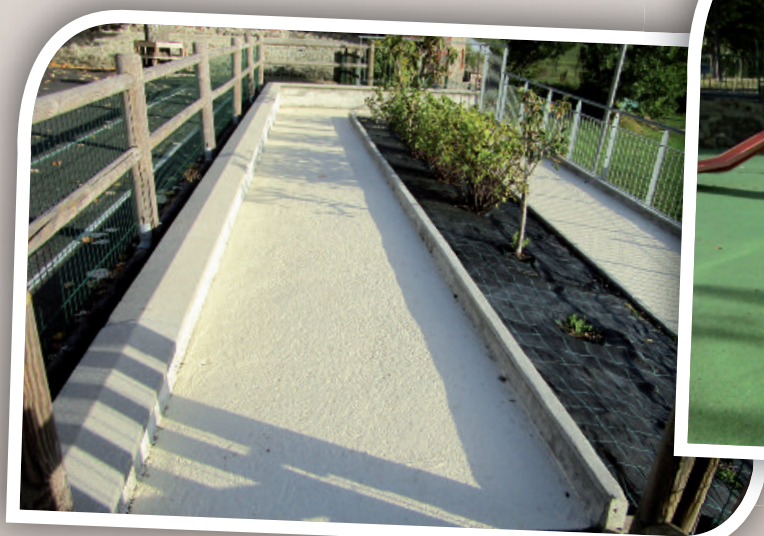
Réfection accès cantine.
