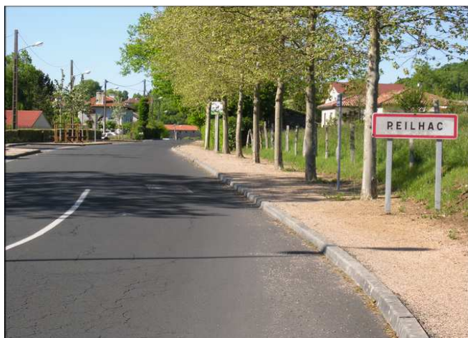
Réfection des routes dans Reilhac en enrobé
