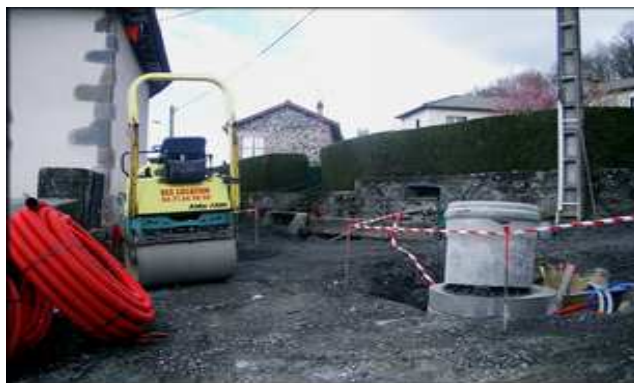
Réfection rues haut du bourg
