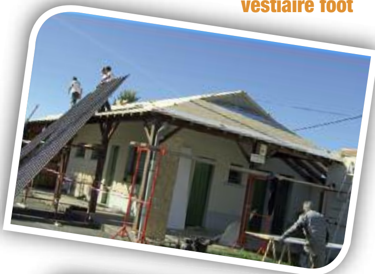
Réfection toiture vestiaire foot
