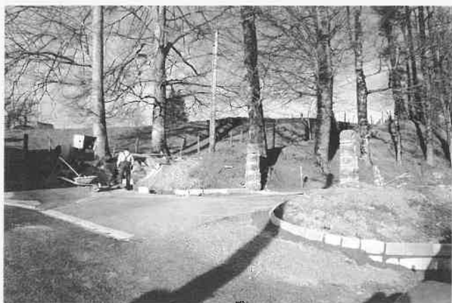
Travaux à "Broussette"
