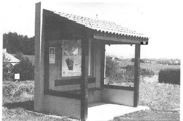
2 abris bus de ce modèle sont en cours d'installation
