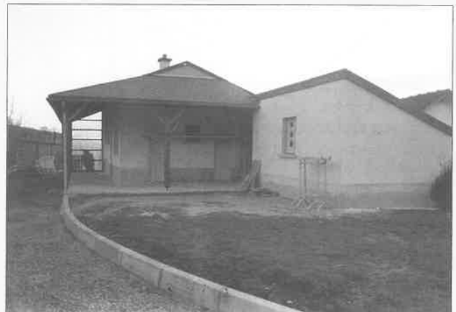
après les travaux
