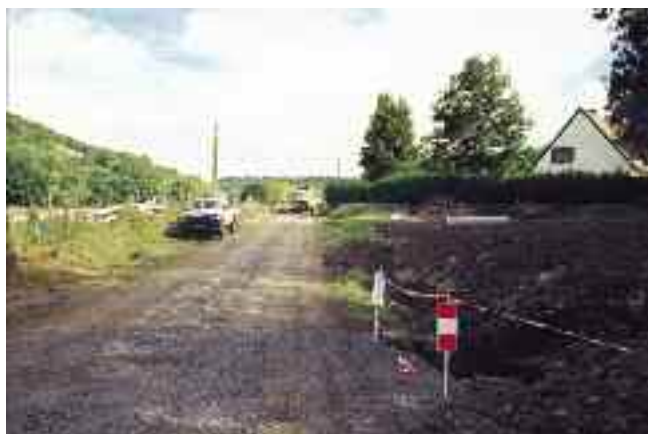
Travaux à Reilhaguet
